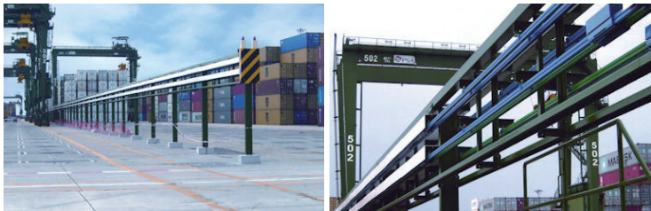
Figura 120. Sistema de electrificación mediante líneas conductoras
