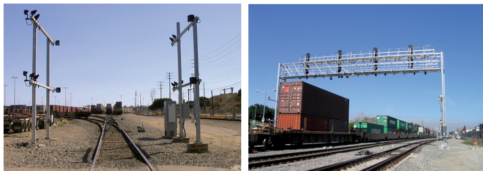
Figura 137. Pórticos para sistemas OCR en los accesos ferroviarios
