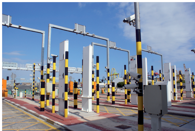
Figura 134. Instalación de sistemas OCR en las puertas del Puerto de Valencia
