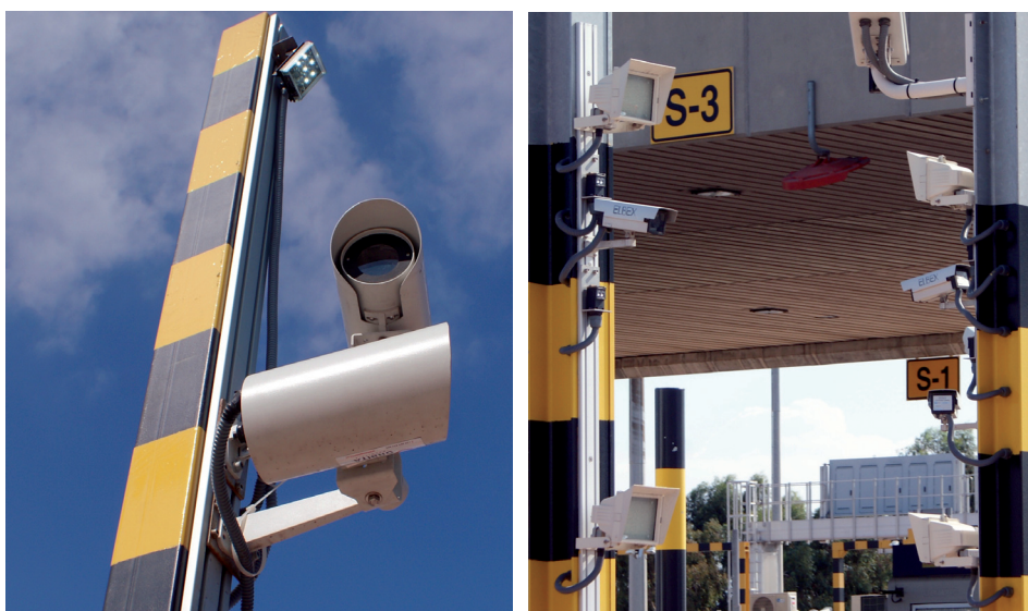
Figura 136. Sistemas de iluminación de apoyo a los sistemas OCR
