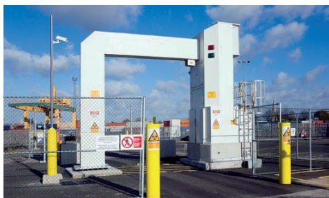
Figura 143. Portal con escáner de rayos X en Southampton Container Terminal (Port of Southampton – Reino Unido)
